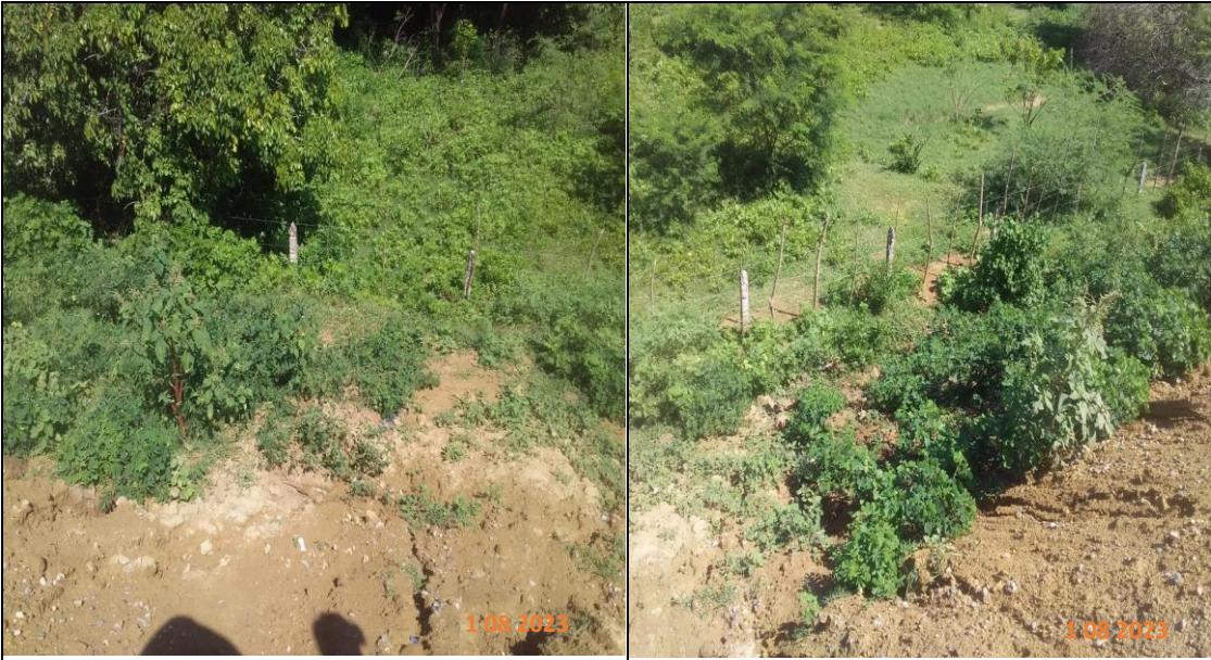
Atención R_37679 Inspección en campo
